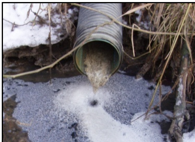
Figur 11. Et utslippspunkt for avløpsvann med for høyt innhold av organisk stoff
