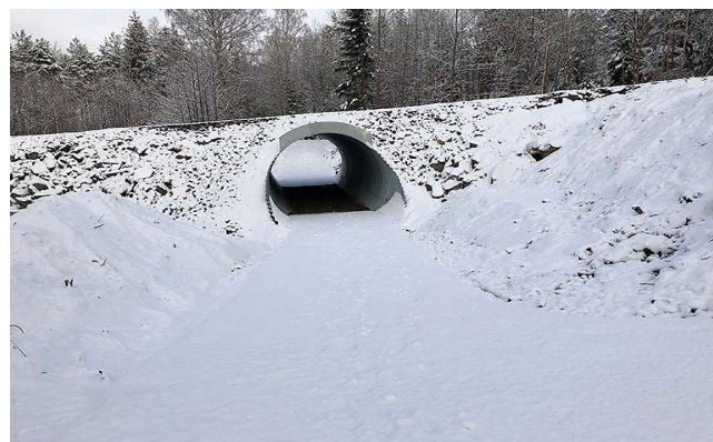
Det er anlagt en gangkulvert/tunnel på rundt 15 meter som sikrer trygg ferdsel for turgåere under anleggsveien i Kongeveien.
