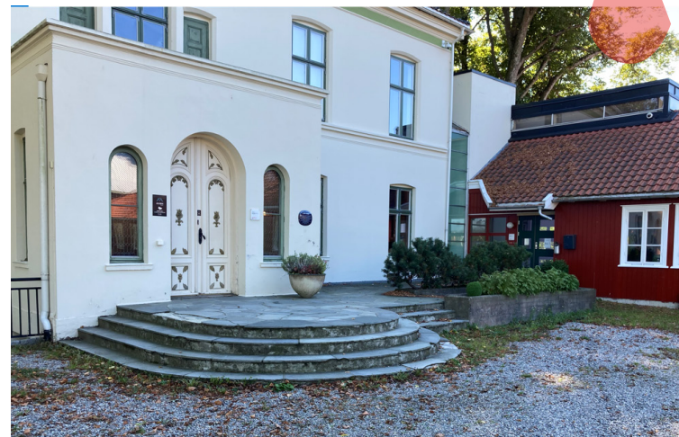
Betongrampe som er i dårlig forfatning skaper ubalanse i aksen og symmetrien i det formelle inngangsområdet
