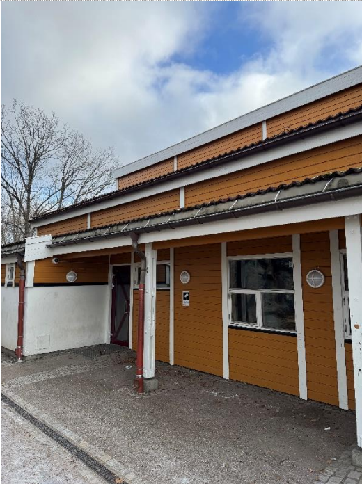
26 Yttertak på barnetrinnet skolen
