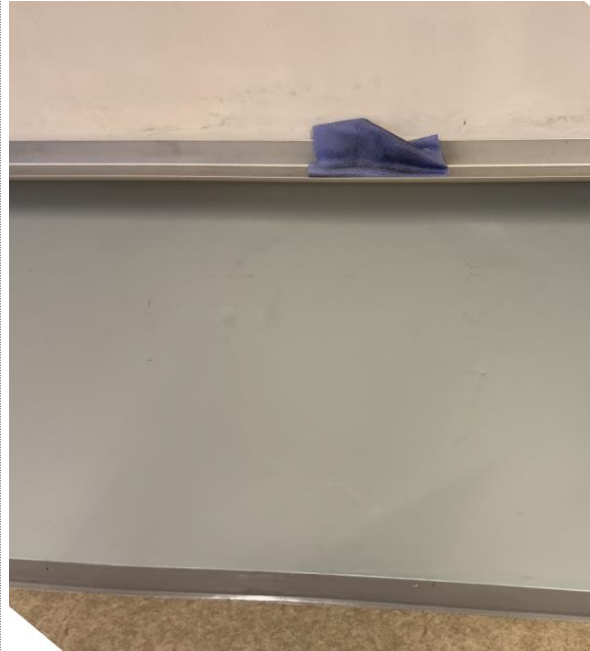
23 Yttervegg. Bom på innside vegg.
