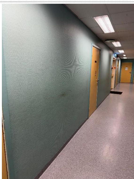
24 Innvendige vegger, overflater
