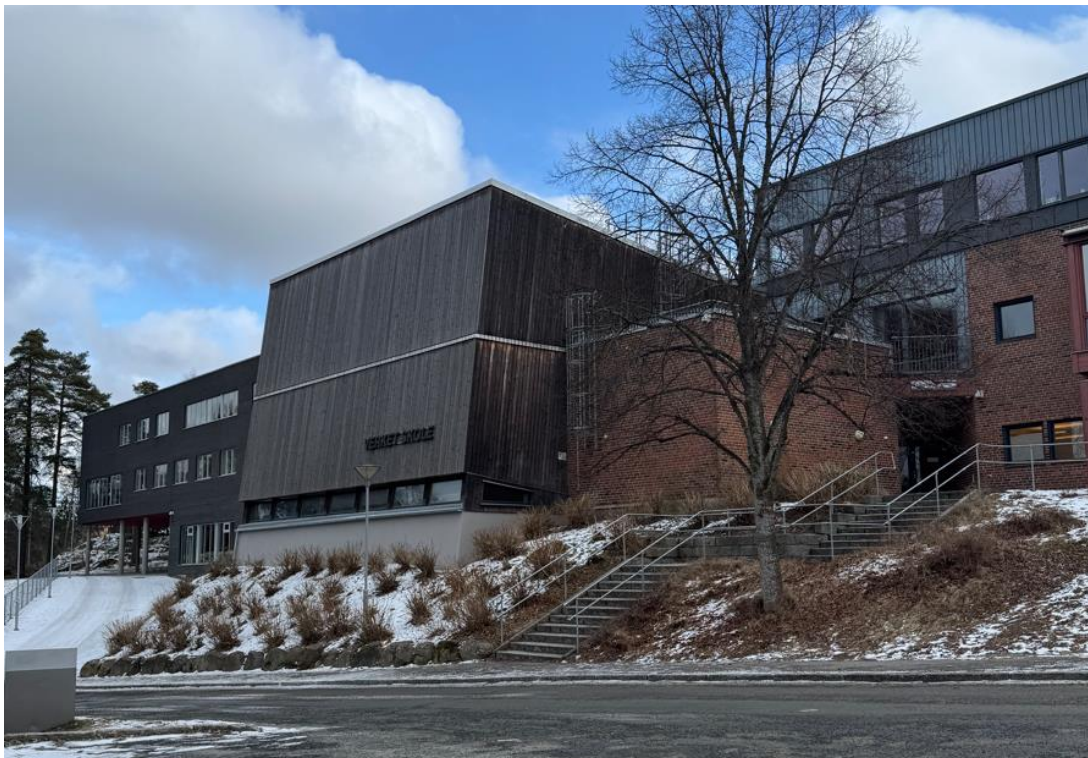
Bilde 25 Bilde fra befaringsdag. Kilde: Norconsult Norge AS
