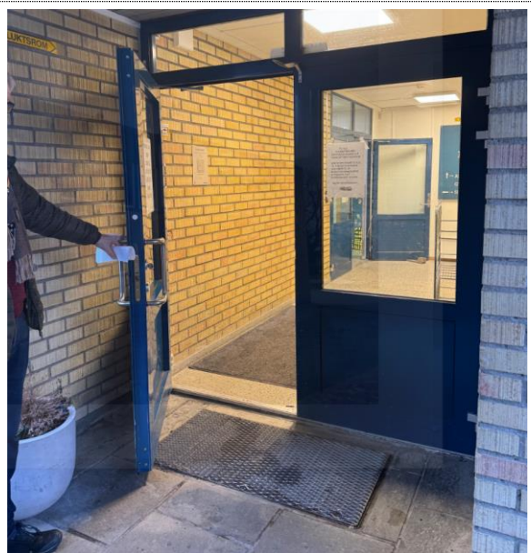
20. Inngangsdør ved hovedinngang
