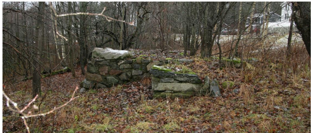
Figur 27 Grunnmur/ stenmur rett nord for Lia. Foto: COWI AS, nov. 2019.
