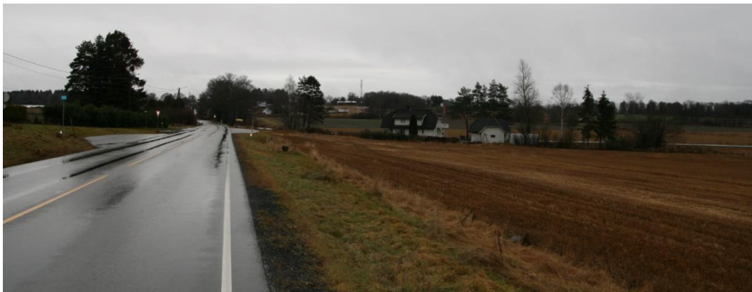
Fylkesveg 119 Larkollveien. Foto: COWI AS, nov. 2019.
