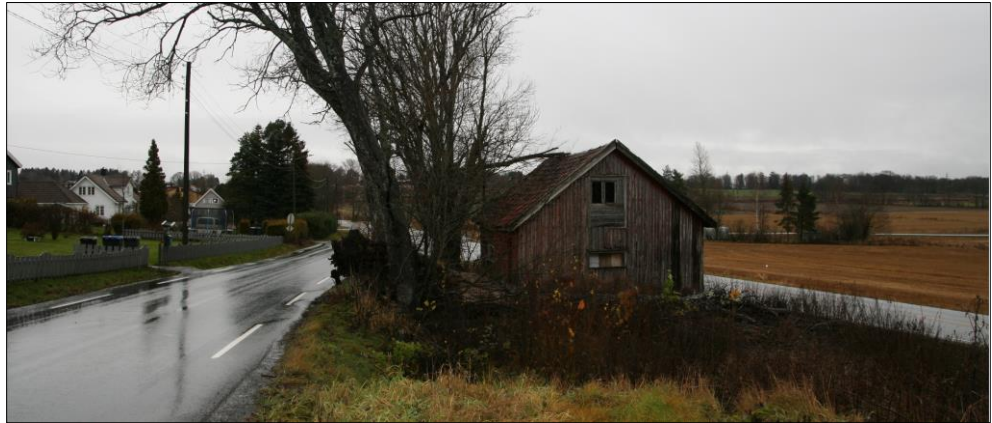
Figur 28 Hønsehuset sett fra sør, beliggende mellom Larkollveien i øst og nordre del av Klosterveien. Foto: COWI AS, nov. 2019.
