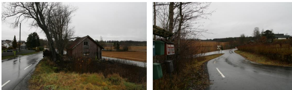
Figur 31 Bildene viser eksisterende kryss fylkesveg 119 Larkollveien x fylkesveg 314 Klosterveien. Til høyre er den nordre armen av Klostervegen, bilde et tatt fra Klostervegen i retning nord. Til venstre er den søndre armen av Klostervegen, bilde tatt fra Klosterveien i retning sør-øst. Foto: COWI AS, nov. 2019.
