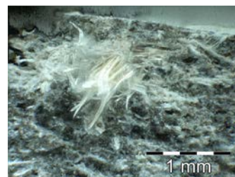
Hvitasbest i bygningsplate
