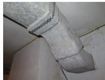
Ventilasjonskanal
