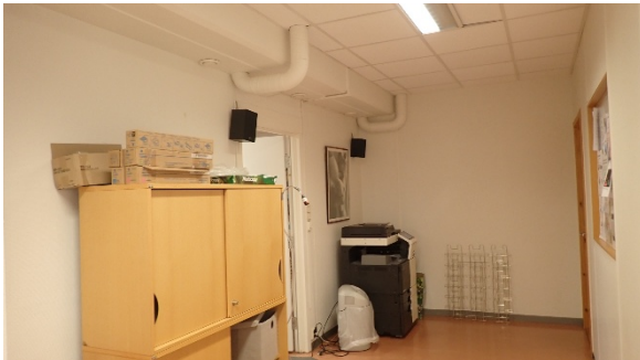
Foto 3. Korridoren mellom venterommet og tre kontorer.
