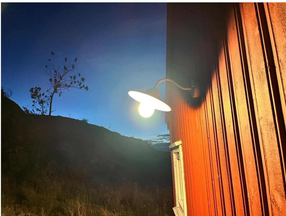
Illustrasjon: Et eksempel på en lampe som sprer lys utover. Skjermen begrenser belysning opp, men litt avhengig av hva man ønsker å belyse, burde skjermen ha dekket mer av pæra for å styre belysningen der det er behov for lys, begrense strølys og hindre blinding.
