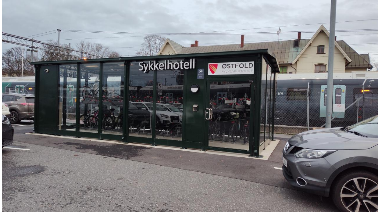
Sykelhotell 1 på vestsiden av Moss stasjon = 42 plasser
