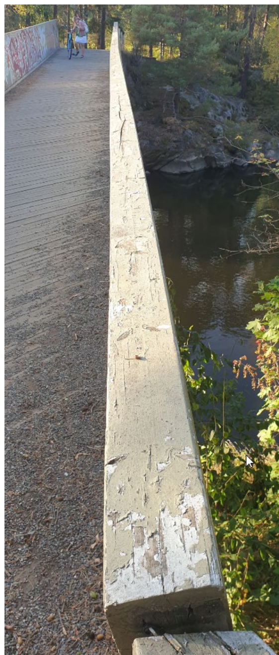
Figur 7: Utbøying vestre bjelke.
