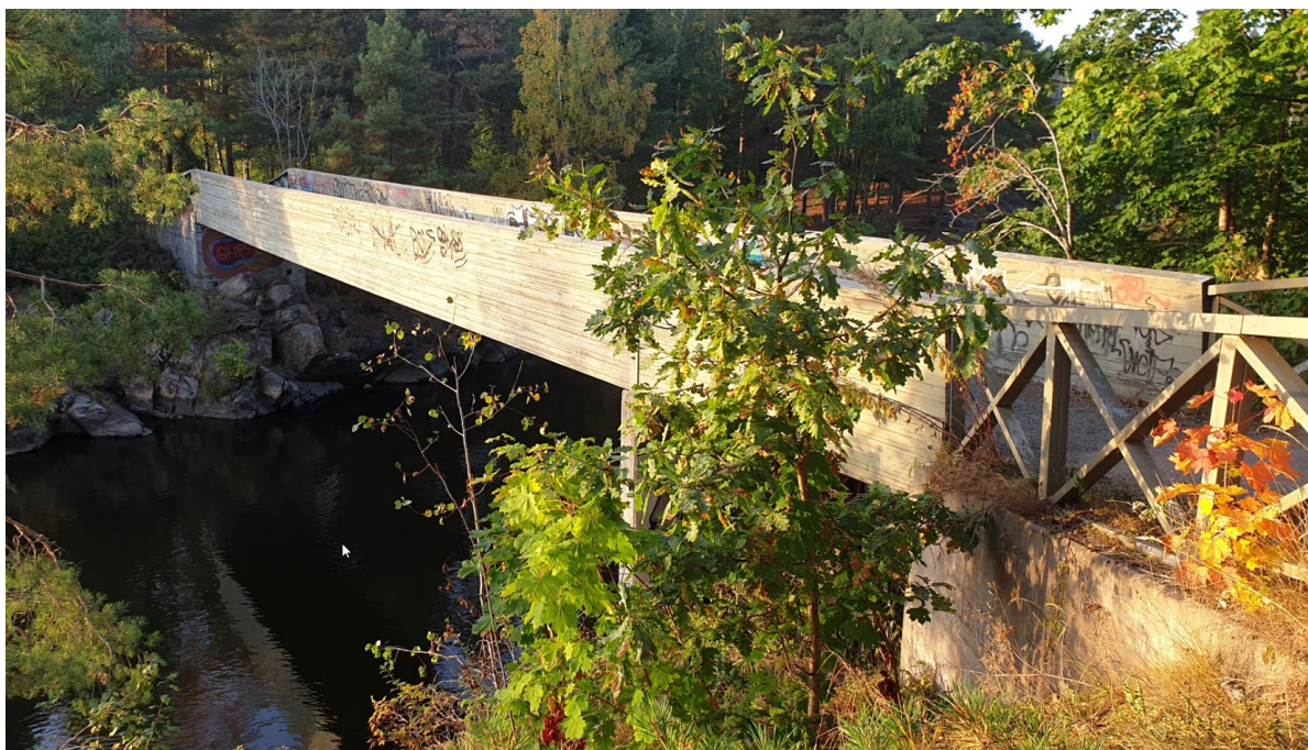
Figur 2: Oversiktsbilde Nesparken gang-/sykkelbru, mot nord. Bildedato 14.09.2021
