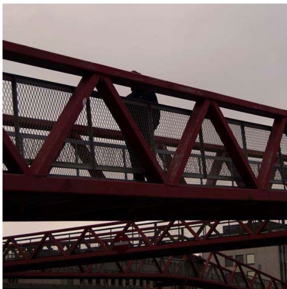
Figur 11: Tidligere gangbru ved Ullevål i Oslo kommune. Kryssing over Ring 3.
