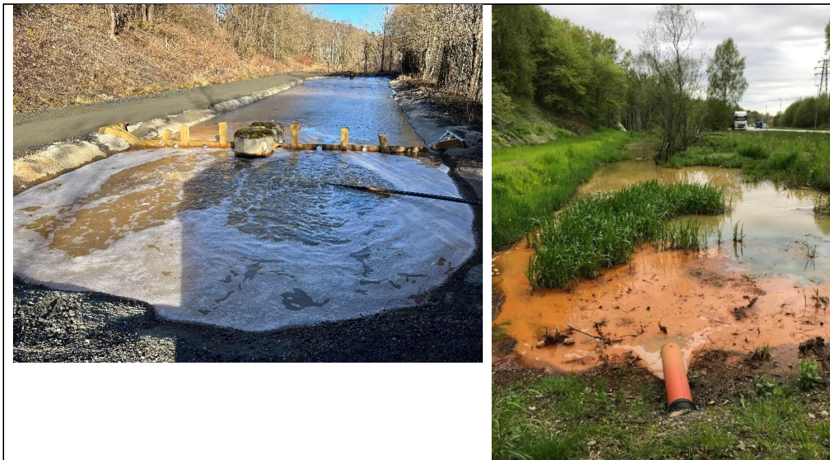
Figur 9 Sigevann fra deponiet i Trolldalen går gjennom en luftet lagune (t.v.) og ledes så ut i en serie av våtmarksdammer (t.h.).
