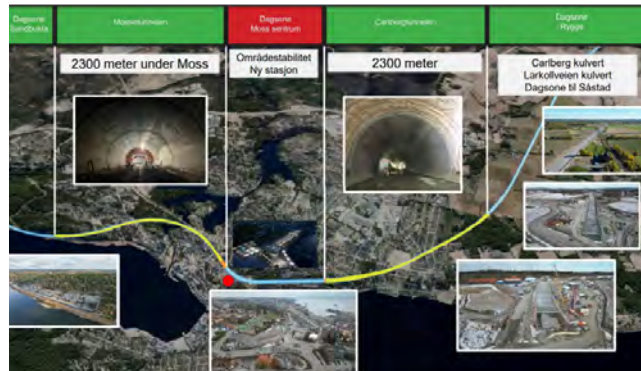
Ny togstasjon bygges
