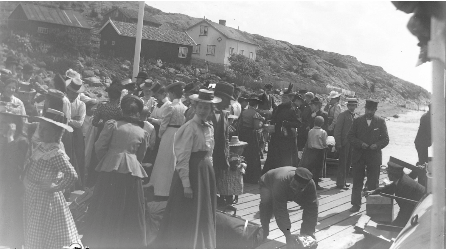
Dampskipsbrygga i Larkollen.
