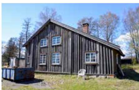
Rørhuset. Foto: Tommy Lund.
