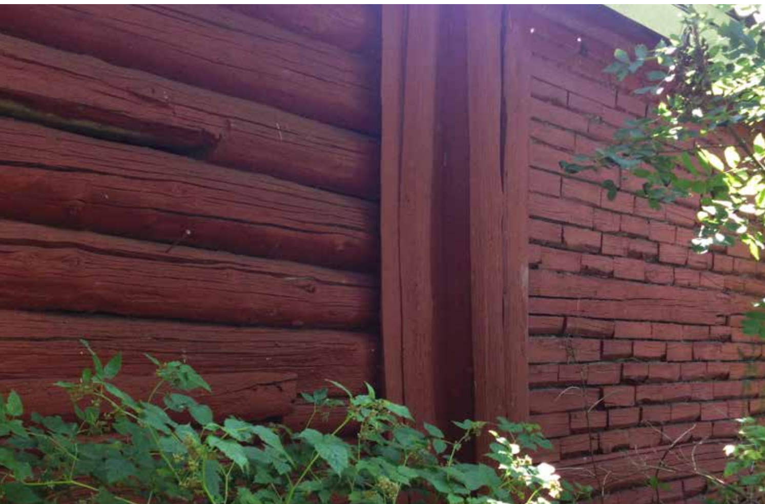
Uthuset på Nasle, byggeteknikk med laft og knubb. Foto: Trine Syvertsen.
