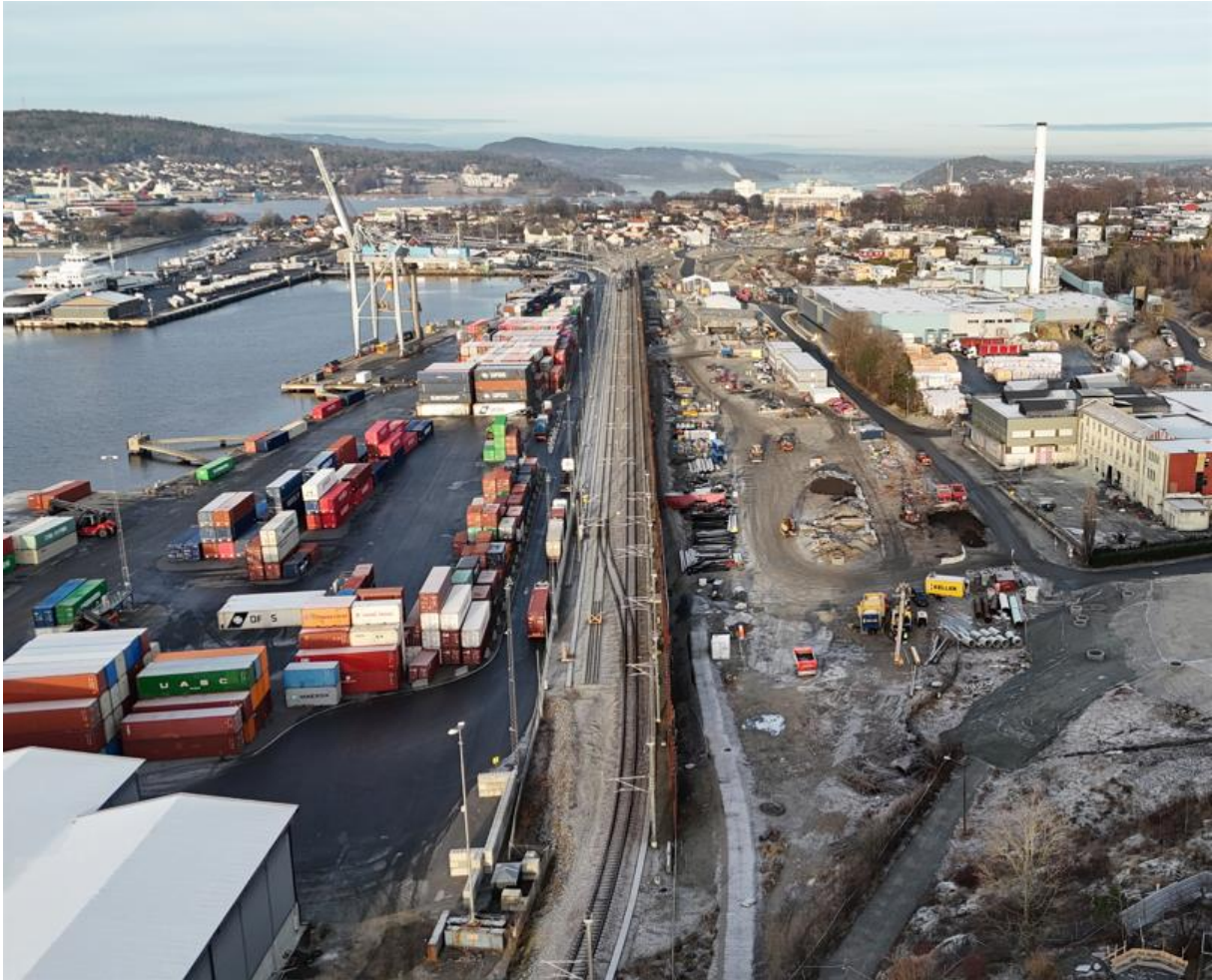
Foto: Sør for Moss stasjon/Bane NOR
