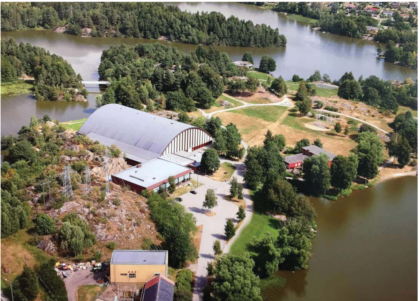
Eksisterende situasjon ved Mossehallen
