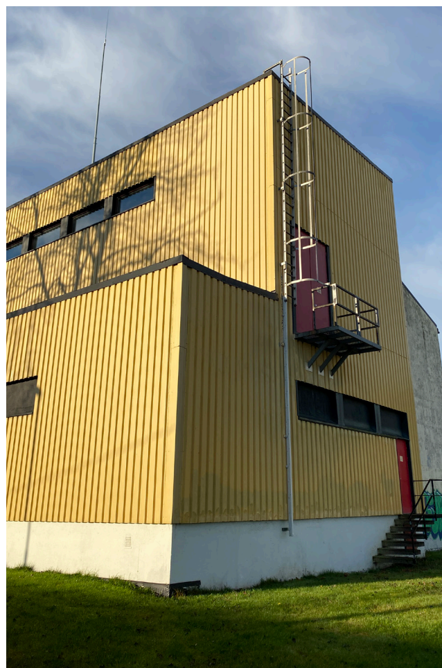
Figur 27. Transformatorstasjon på Melløs.
