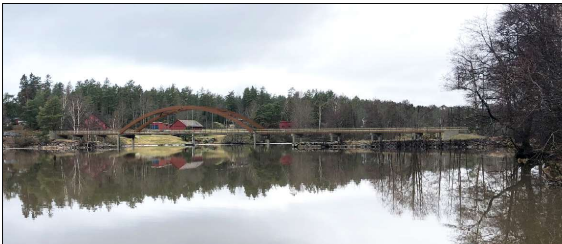
Figur 19: Alternativ 3 Lang bru på søyler oppå dagens landkar og tilløpsfyllinger. Sommeren 2020 har Våler kommune etablert en tilrettelagt strand langs store deler av tilløpsfyllingen. Denne vises ikke på bildet.
