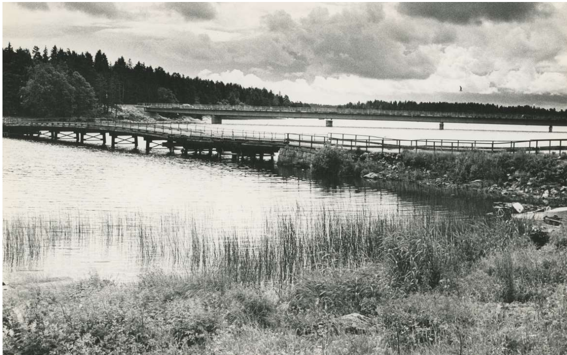
Figur 20. Fotografi fra 1972 med tidligere Rødsund bru foran i bildet, og dagens Rødsund bru bak. Kilde: digitaltmuseum.no
