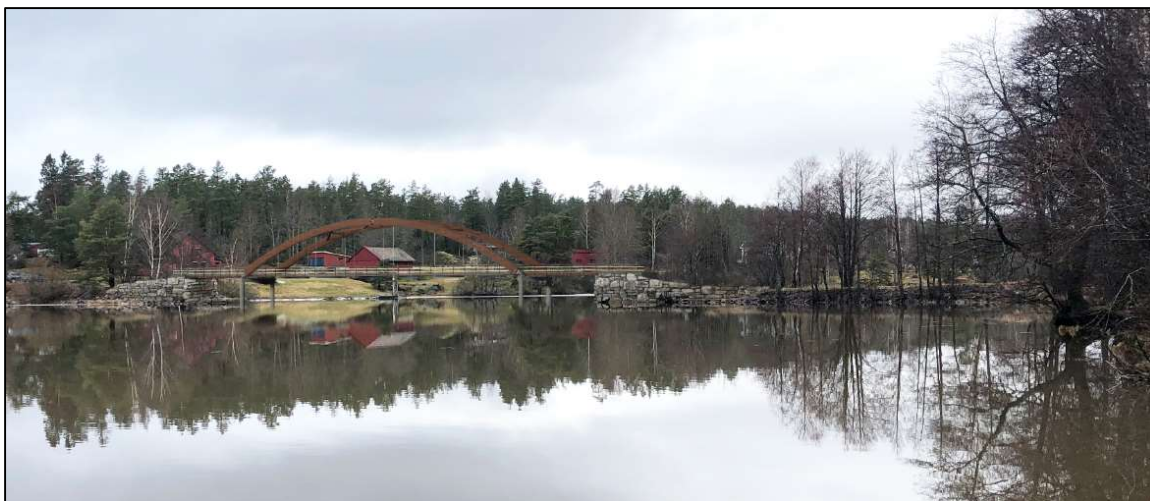
Figur 18: Alternativ 2 Kort bru med oppmurte landkar på dagens landkar og tilløpsfyllinger. Sommeren 2020 har Våler kommune etablert en tilrettelagt strand langs store deler av tilløpsfyllingen. Denne vises ikke på bildet.
