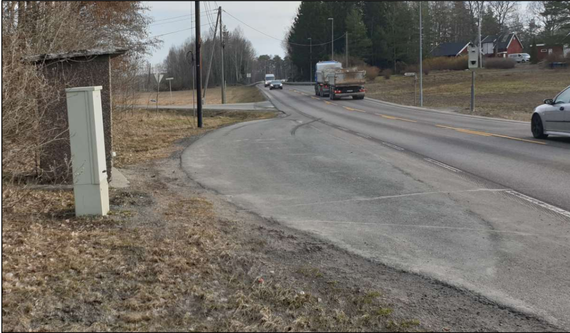
Figur 13. Bildet viser Kolsrød bussholdeplass (vestgående) og krysset fylkesvei 120 Vålerveien x Kolsrødveien.
