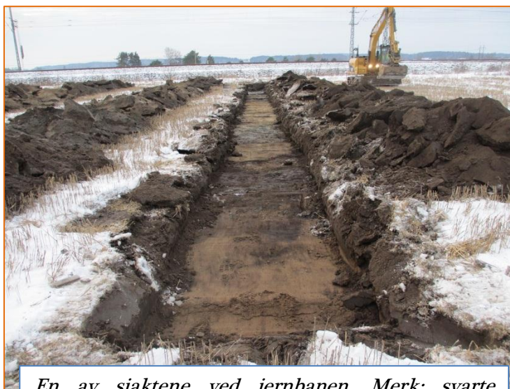
En av sjaktene ved jernbanen. Merk: svarte torvflekker og finkornet sand som drenerer dårlig.
