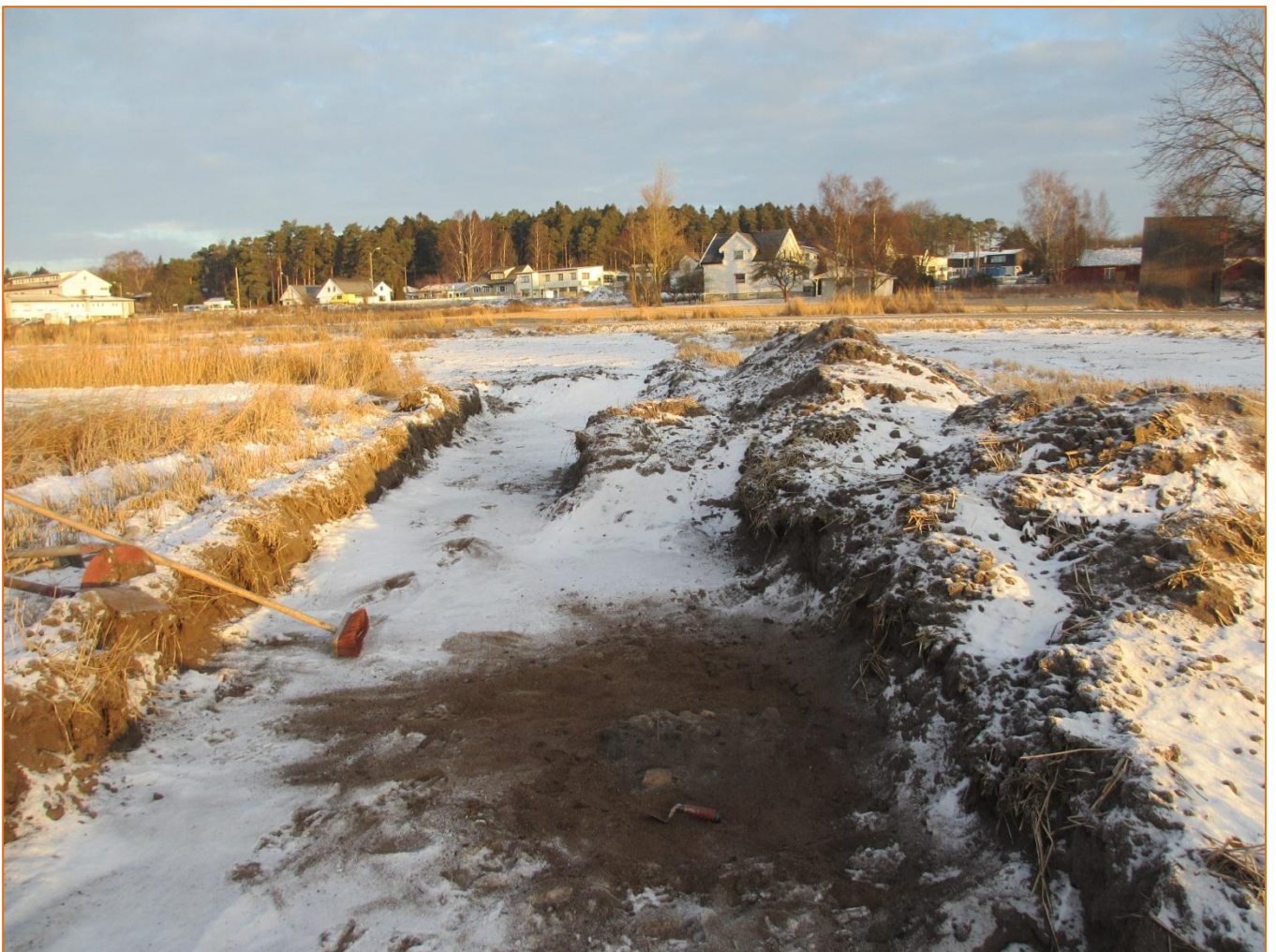
Sjakt 148 sett mot nordnordøst. A36 sees over graveskeia.
