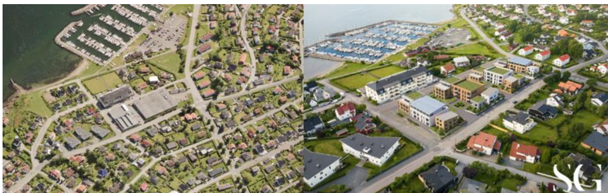
figur 1 – oversiktsbilde og situasjon etter tiltak
