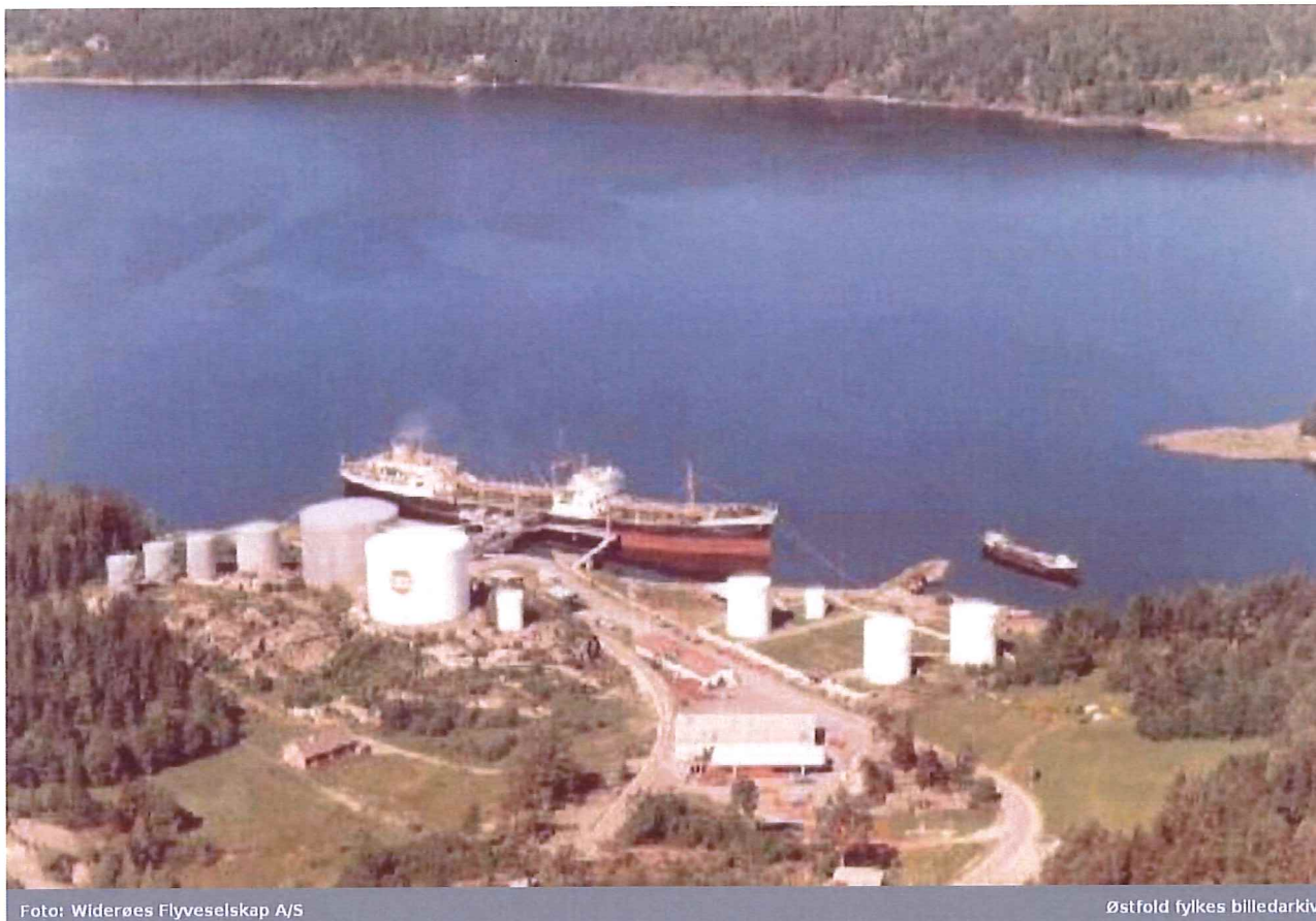
Figur 3 Gammelt bilde av tankanlegget (Kilde: Østfold fylkes billedarkiv)
