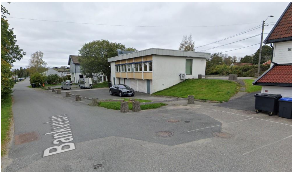
Planområdet sett fra Bankveien - Google street view
