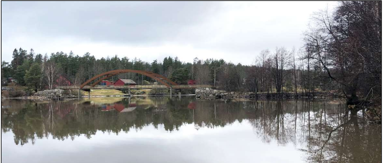
Figur 3-7: Alternativ 2. Kort bru med oppmurte landkar på dagens landkar og tilløpsfyllinger. Kilde: Multiconsult
