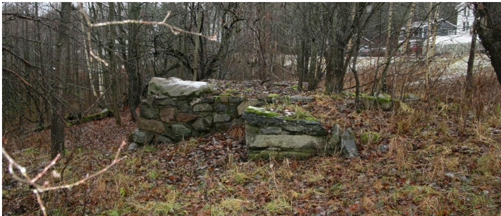
Figur 31 Grunnmur/stenmur rett nord for Lia. Foto: COWI AS, nov. 2019.
