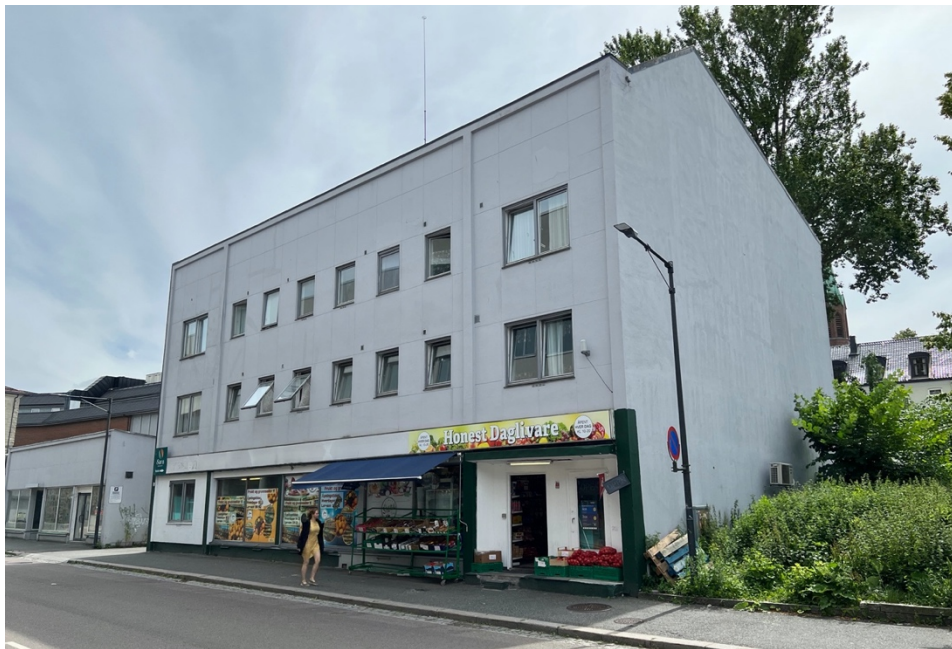
Foto av eksisterende bebyggelse på eiendommen.
