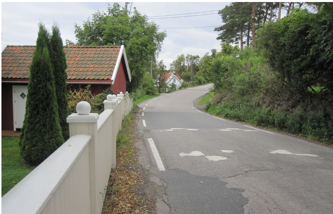
Figur 25 Annekset i Tollbuveien 1 må fjernes for fremføring av fortau (Viken fylkeskommune).
