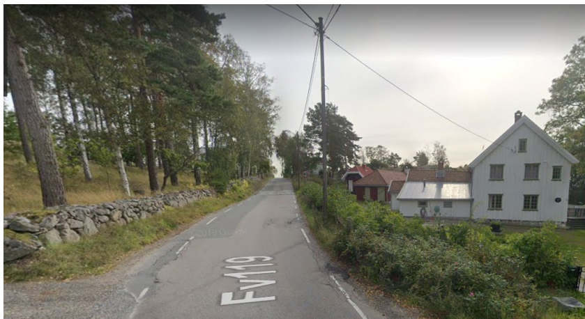
Figur 39 Den fredete Tollstasjonen til høyre i bildet, og steingjerdet som skal flyttes til venstre i bildet (Google maps).
