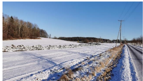
Utskifting av «gammel bekkelukking»
